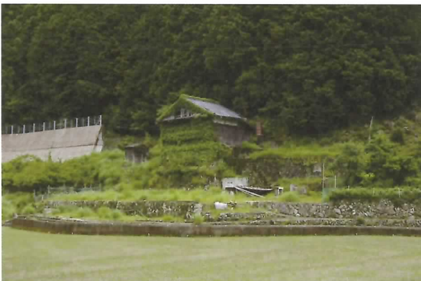
図1. 石を積んで基礎を高くした家
